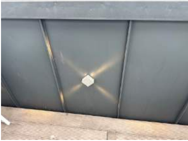
Armatyr på vägg
